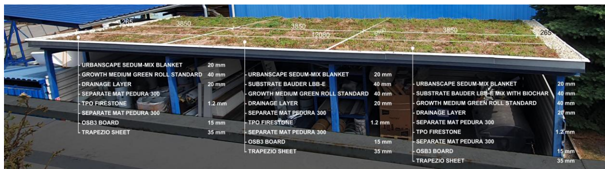
Obr. 4.4 Fáza 2 prístrešok pre skladovanie materiálu s vegetačnými strechami a ich skladbami foto: august 2021
