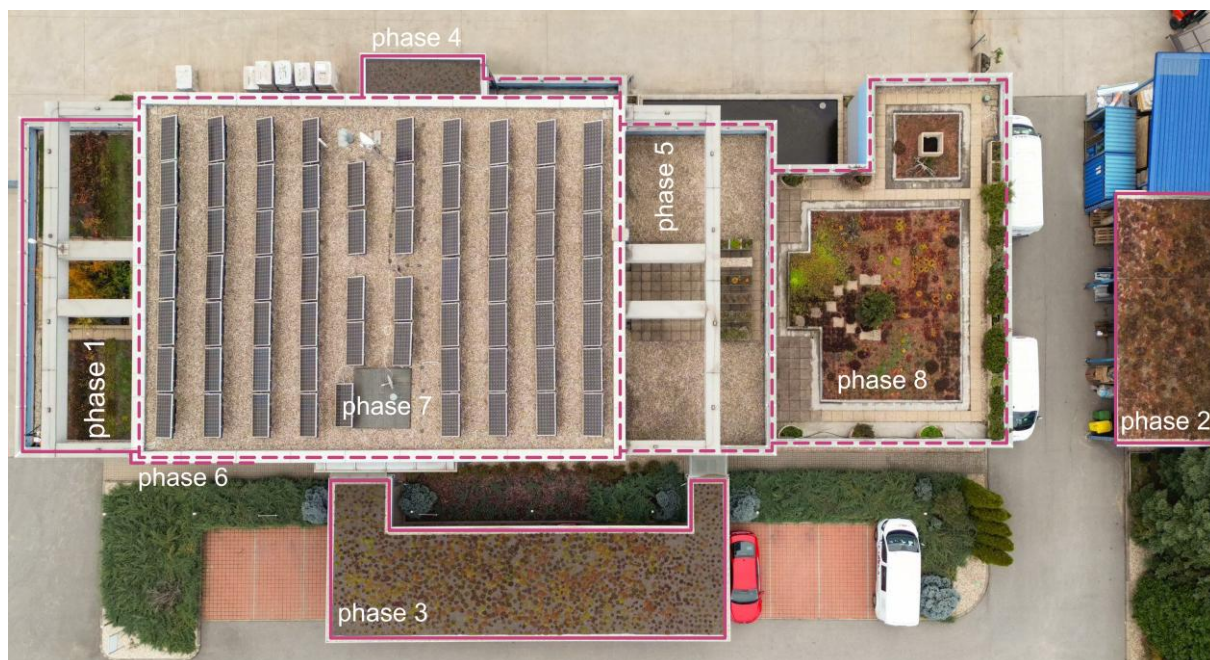
Obr. 4.2 Pohľad na strešné konštrukcie areálu s rozdelením na jednotlivé fázy projektu greenIZOLA
