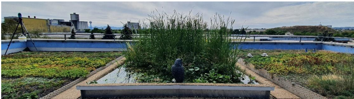
Obr. 4.15 Transformácia referenčného segmentu na experimentálnu mokrad'ovú strechu foto: september 2022
