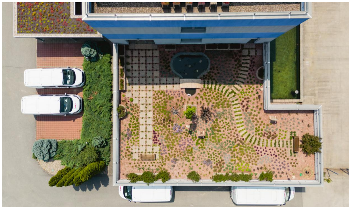
Obr. 4.10 Intenzívna vegetačná strecha na severnej terase 2. NP
