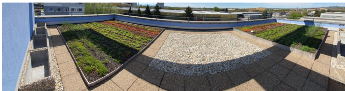
Obr. 4.3 Experimentálna vegetačná strecha na južnej terase 2. NP
