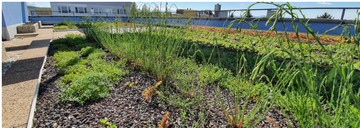
Obr. 4.7 Vegetačná strecha na severnej terase 4. NP
