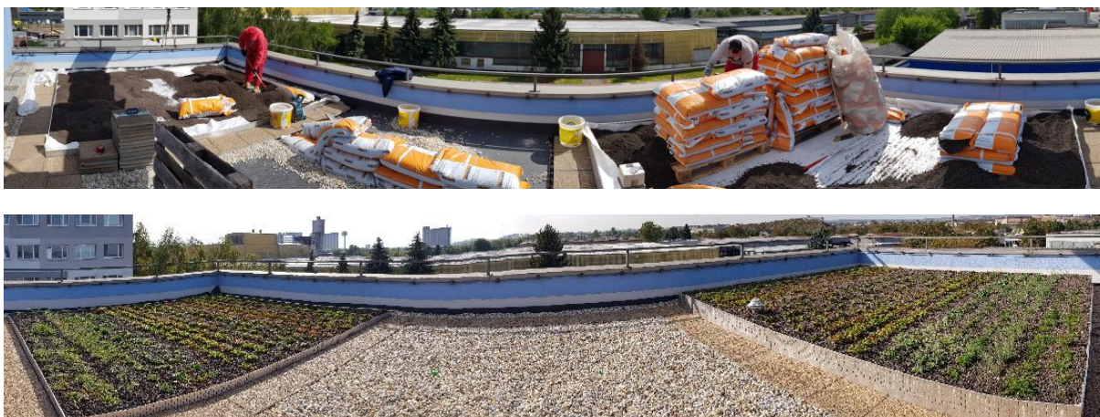
Obr. 4.12 Príprava strešnej konštrukcie pred realizáciou experimentálnej vegetačnej strechy
