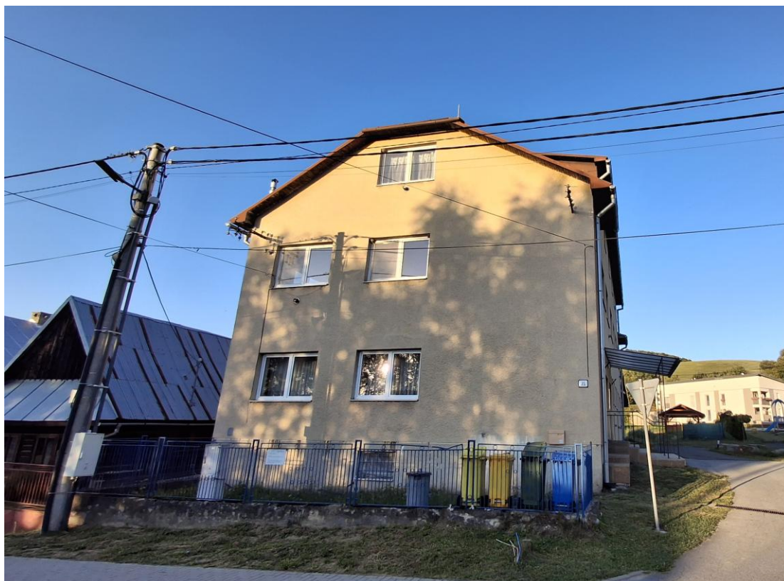
Obr. 8.1 Pôvodná budova kultúrneho domu pred rekonštrukciou – bočný pohľad
